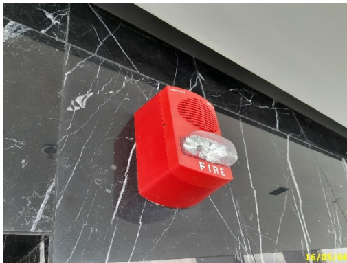
อุปกรณ์แจ้งเหตุด้วยแสง และเสียง
